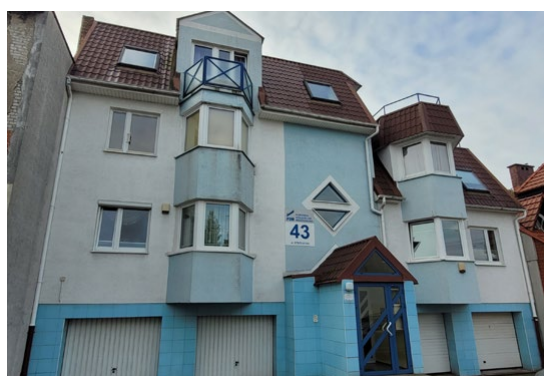
Strzelecka 43 - przed i po remoncie elewacji
