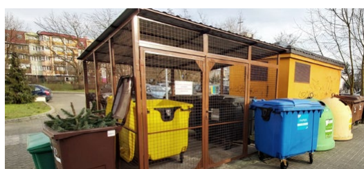
Gołębia 63 i 65 - przed i po remoncie składowiska na odpady
