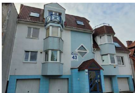
Strzelecka 43 - przed i po remoncie elewacji
